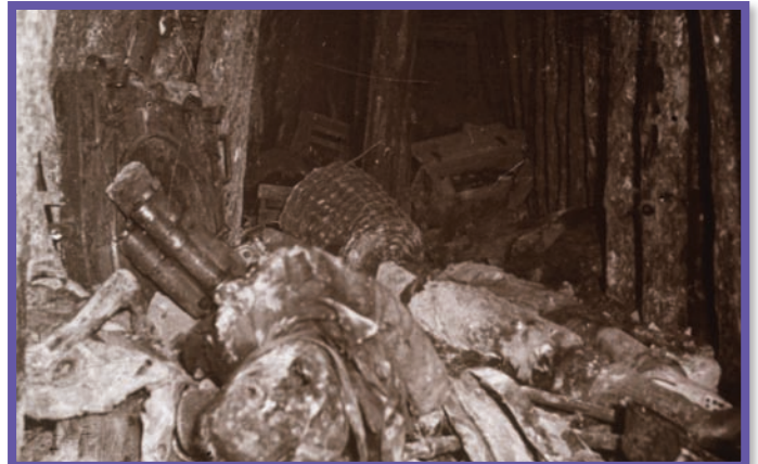
Galerie du tunnel (Fort de Douaumont).
