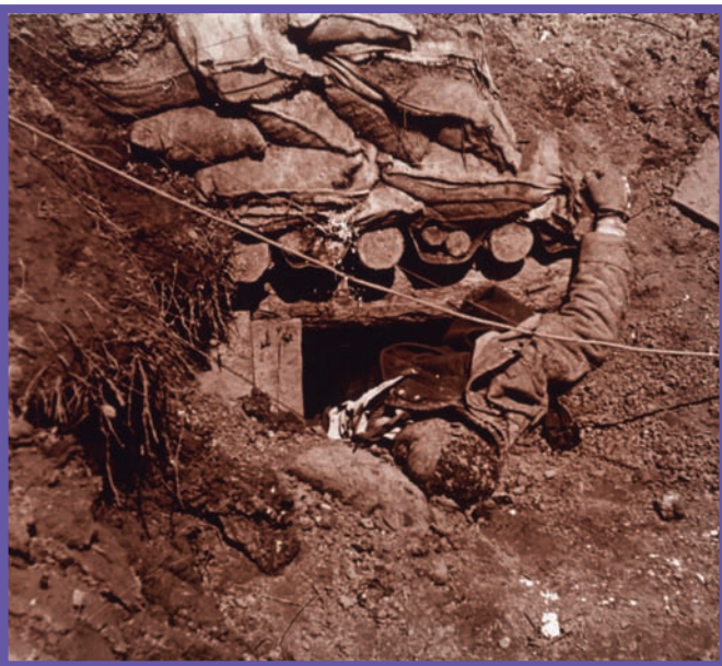
Poste de secours éffondré.
