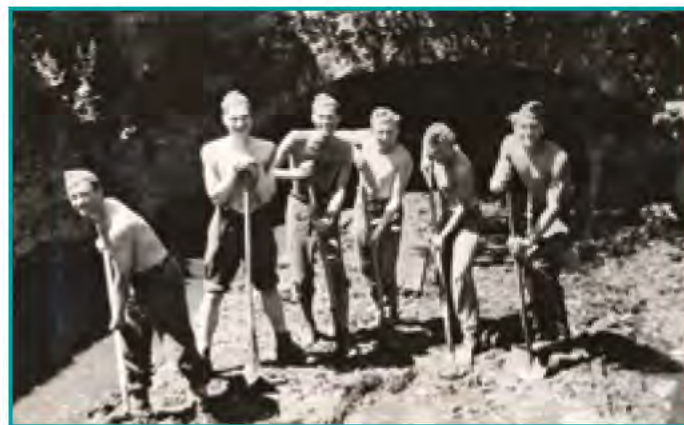
Déblayage d'un tunnel à Bitschwiller-lès-Thann, été 1944. Tout à gauche : Hans Tveten. Photo Jostein Leidulf Hæskja. MUV680339, Université d'Oslo.
