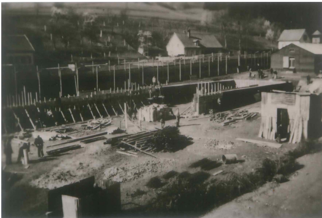
Coll. Mémorial Alsace-Moselle Construction du grand atelier au Camp de Schirmeck
