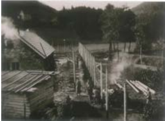
1 - Début de la construction du camp de Schirmeck (MAM - Fonds WEINLING)
