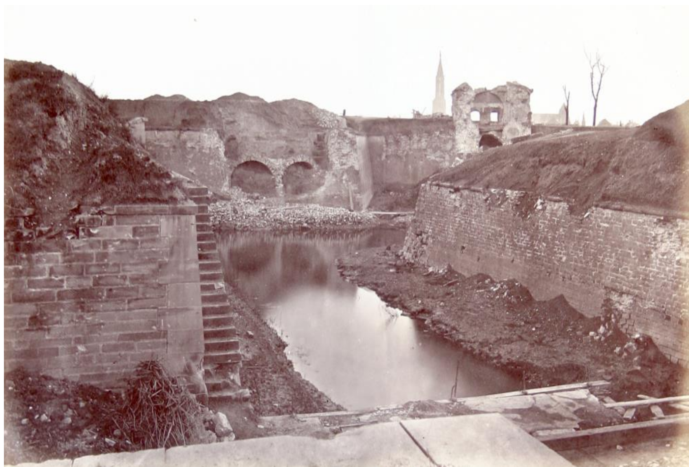
État d'une des portes de la citadelle. Photo Charles David Winter numérisée par Thierry Hatt
